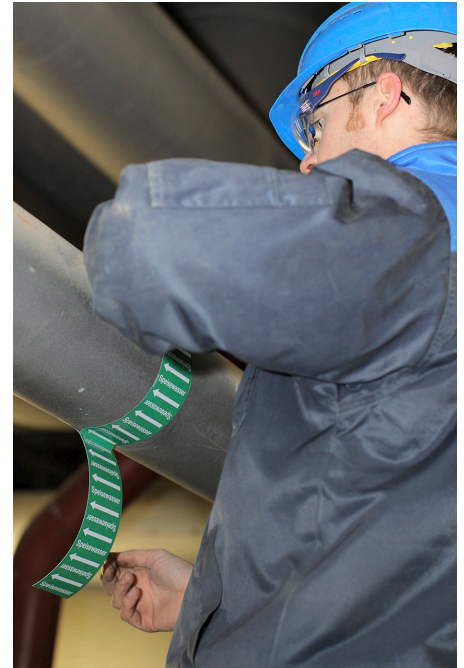
Montage der Rohrkennzeichnung.
